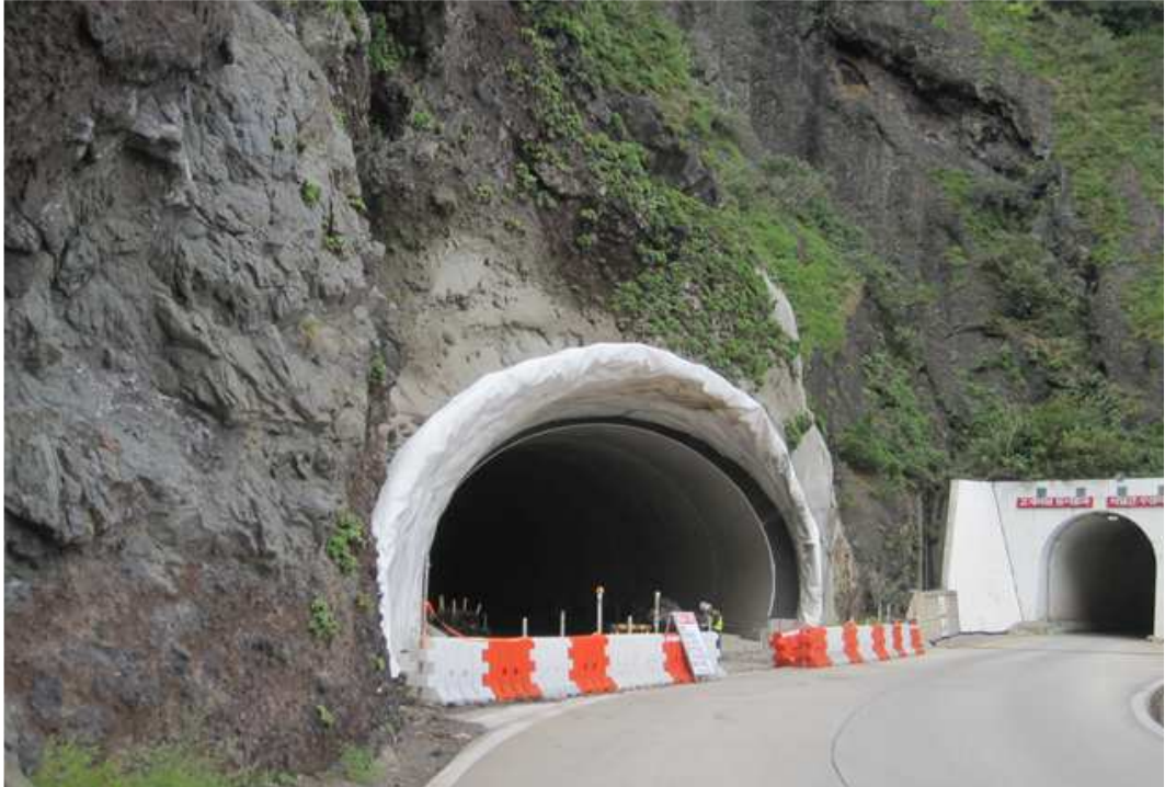
서면1터널 시점부 갱구 전경
