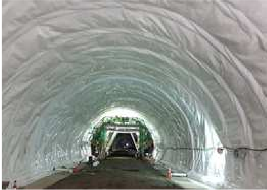
방수쉬트 시공 현황
