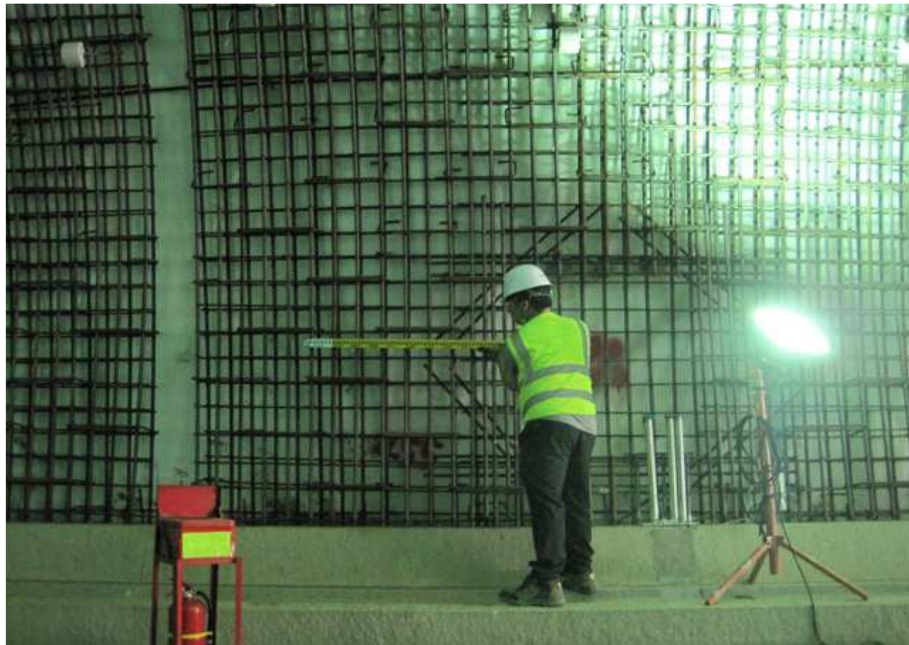
철근 배근 현황
