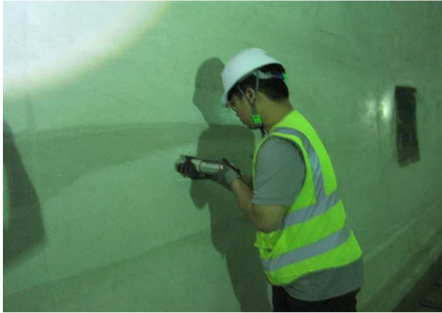
라이닝 콘크리트 강도 측정
