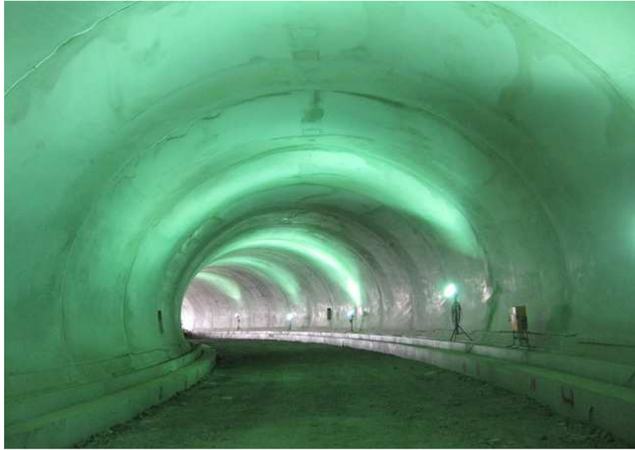
라이닝 콘크리트 현황
