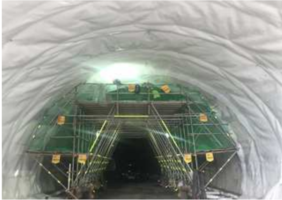
방수쉬트 시공 현황
