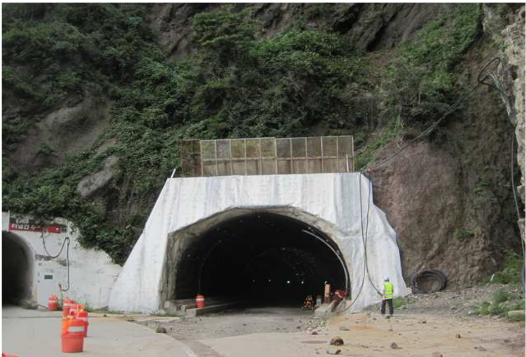
서면1터널 종점부 갱부 전경
