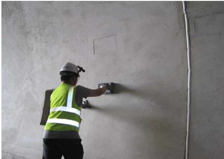
철근 배근 현황
