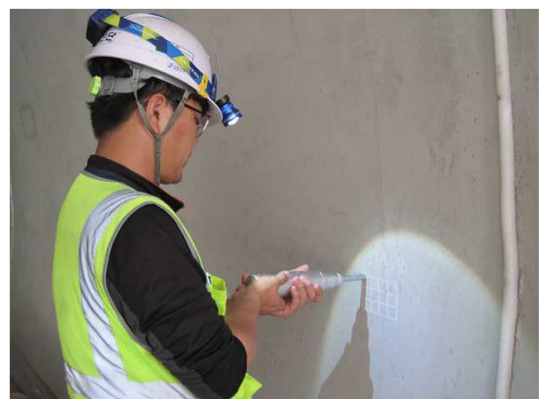
라이닝 콘크리트 강도 측정
