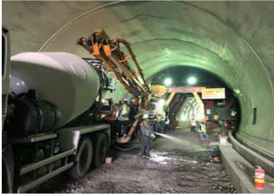
라이닝 콘크리트 현황
