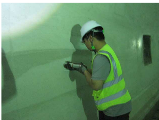
라이닝 콘크리트 강도 측정
