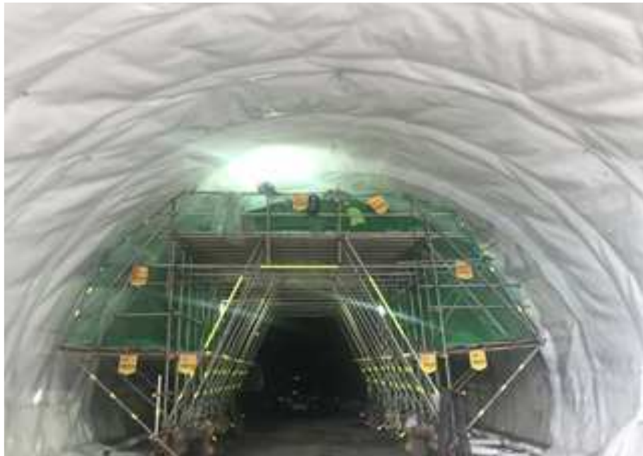
방수쉬트 작업 가시설 현황
