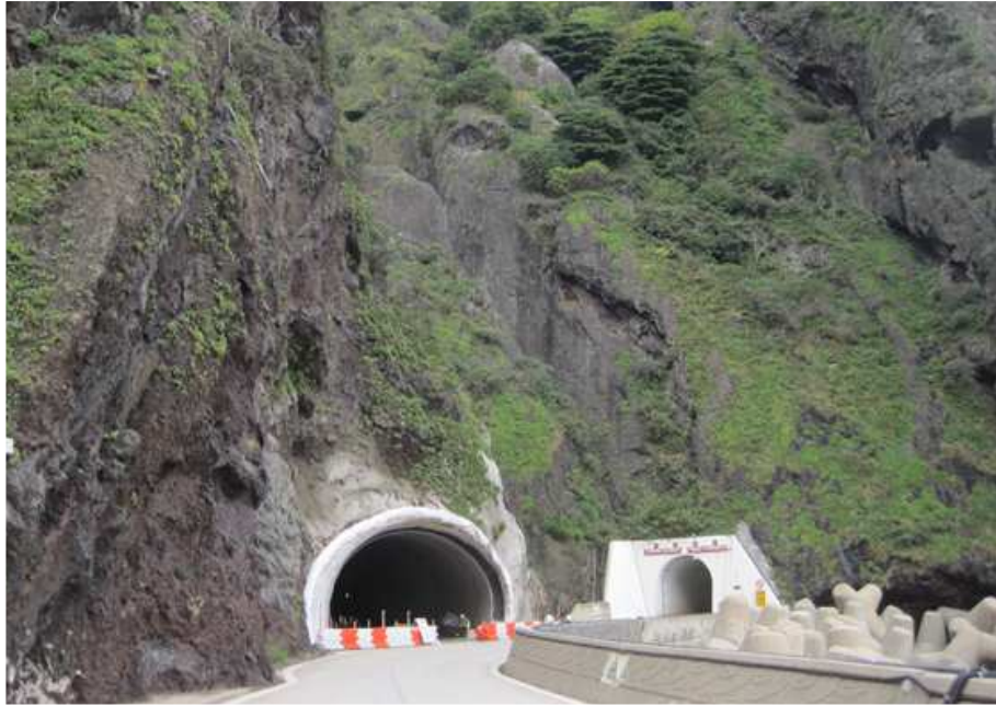
서면1터널 시점부 갱구 전경
