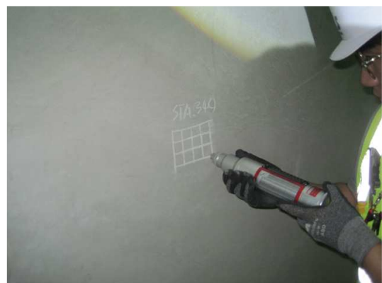
라이닝 콘크리트 강도 측정
