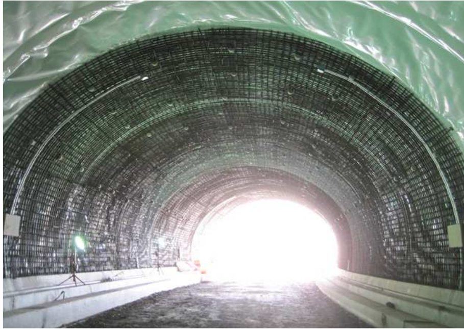
철근 조립 및 배근 전경
