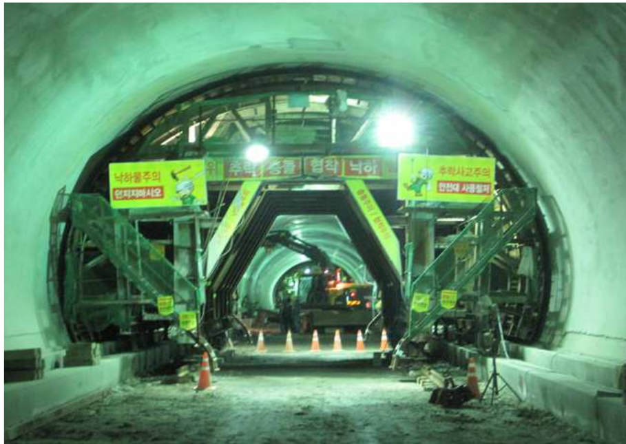
라이닝 콘크리트 현황
