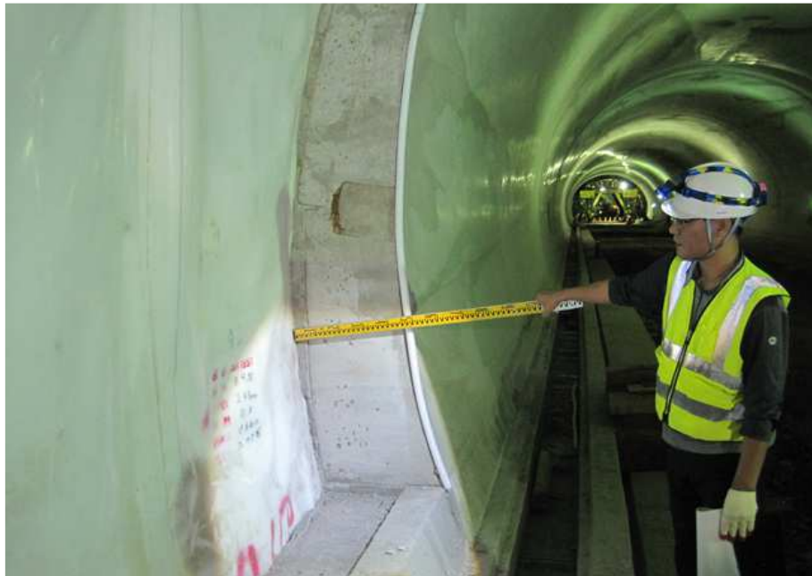
라이닝 콘크리트 현황
