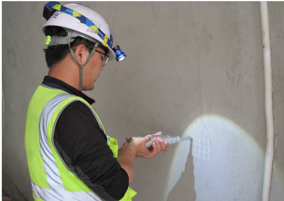
라이닝 콘크리트 강도 측정
