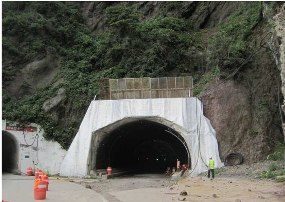
서면1터널 종점부 내부 전경
