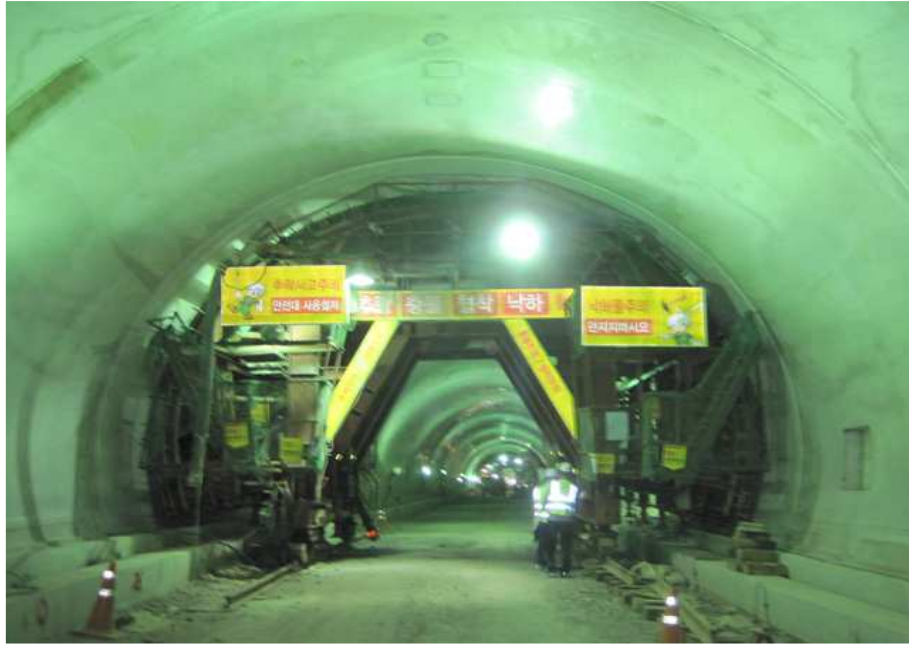
라이닝 콘크리트 타설 가시설 현황
