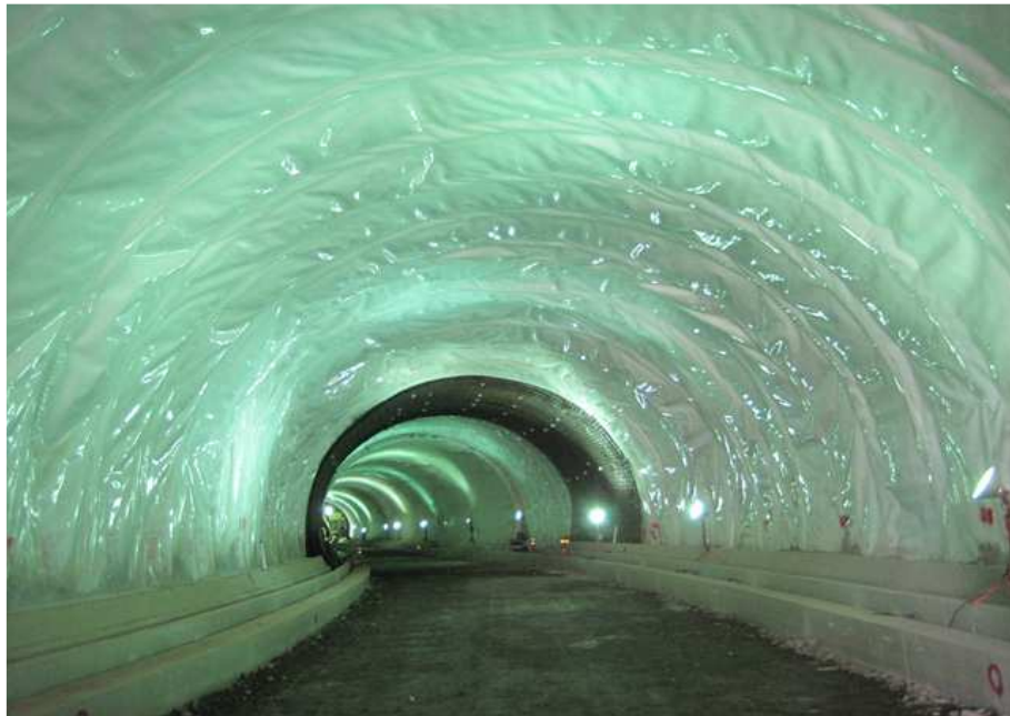
방수쉬트 시공 현황
